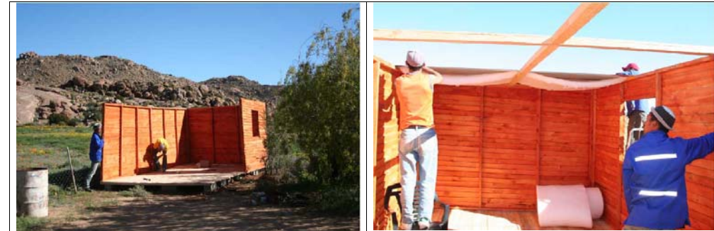
Der Aufbau des Wendy Hauses war gar nicht so einfach. Unter das Dach kam eine Isoliermatte, vor allem damit es im Sommer nicht zu heiß wird.
